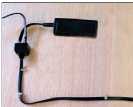
La segunda hembra conectada ya al módulo anterior mediante el cable con conector "western" macho del "bus LocoNet" del módulo anterior.
